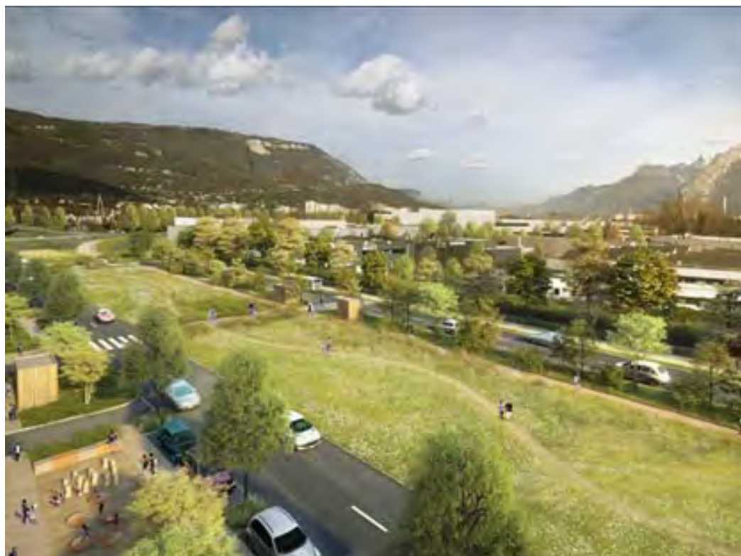
Figure 7 : Vue aérienne de la dalle au-dessus de la tranchée du Rondeau depuis la rue du Tremblay, principe d'aménagement
