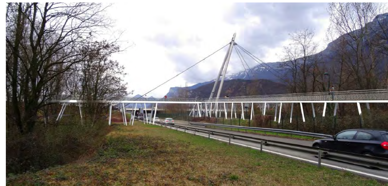
Figure 13 : Passerelle au dessus de la bretelle A480N vers RN87 : Vue depuis la bretelle en direction du Sud
