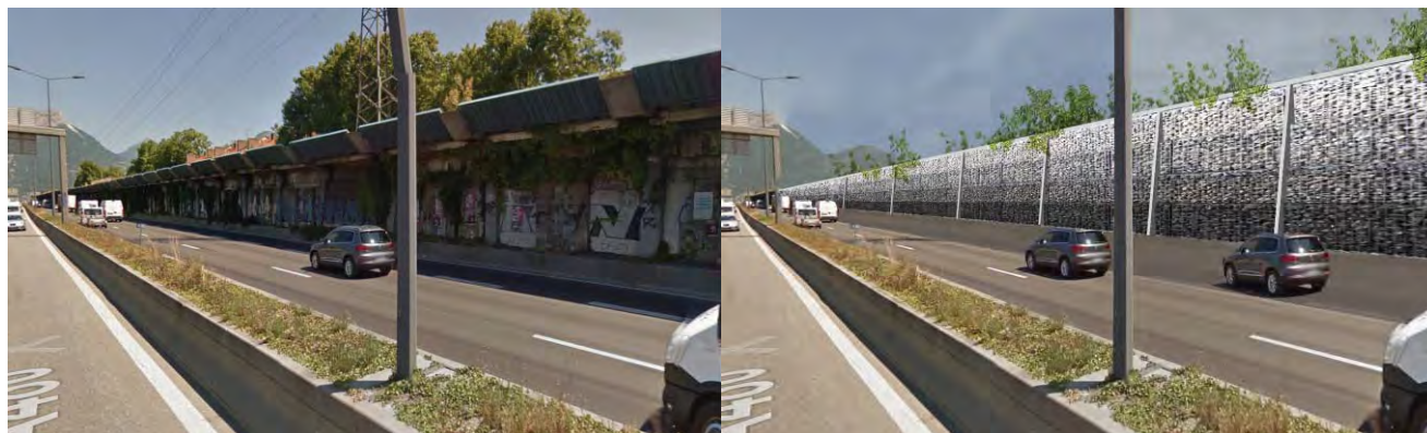
Figure 15 : Vue de principe du traitement architectural de l'écran acoustique Mistral. Etat actuel (à gauche) et état futur (à droite) (© Ingerop)
